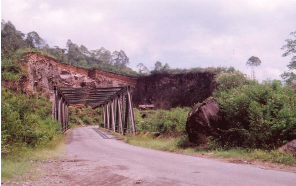
Gambar 16. Jembatan yang melintasi sungai Wae Reno (sebelah utara-barat laut), termasuk ke dalam Kawasan Rawan Bencana II untuk aliran. Foto: Deden Wahyudin, 2009.
